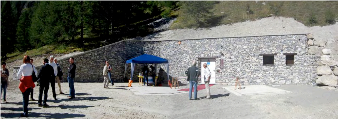
L'esterno della centrale idroelettrica Delle Fie Maurin- 21 settembre 2013.
